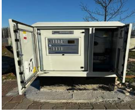
Tıp Fakültesi Kavşağı Yenilenen Kavşak Kontrol Cihazı
