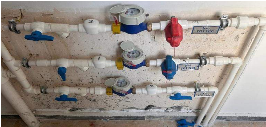
Tespit sırasında uygunsuz görülen ve tekrar yapıp plaka verilen su sayaçları
