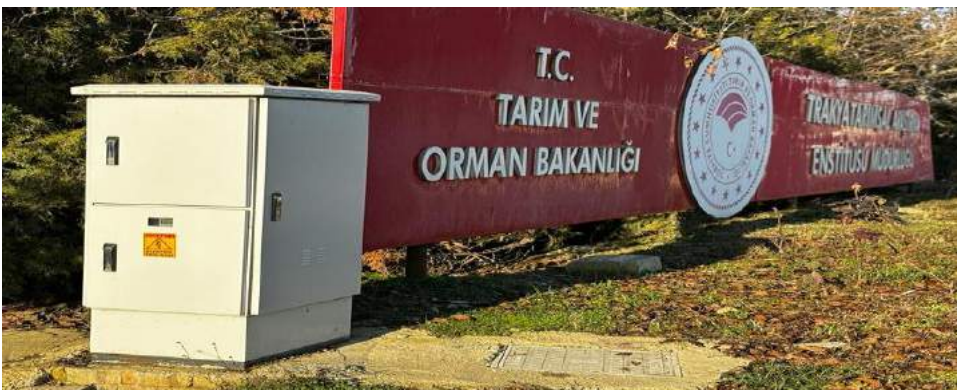
Tarımsal Araştırma Enstitüsü Butonlu Yaya Geçidi Projesi Kavşak Kontrol Cihazı
