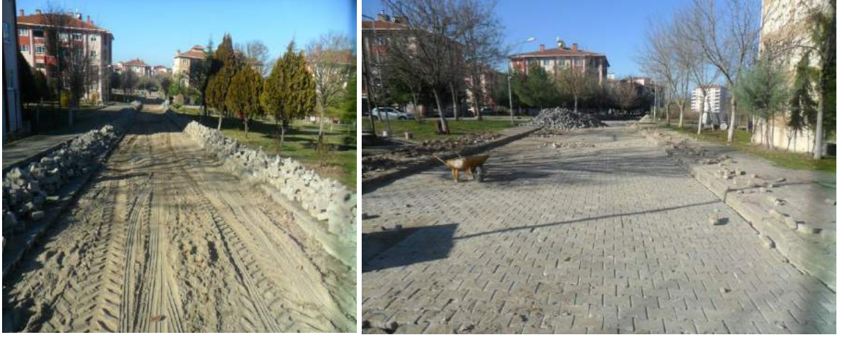
Barutluk Mahallesi Beton Parke Taş Yapılması
