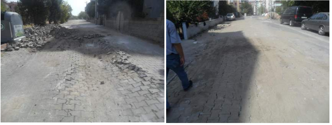
Şükrüpaşa Mahallesi Beton Parke Taş Yapılması
