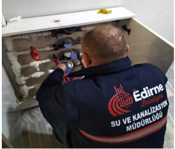
Tespit sırasında uygunsuz görülen ve tekrar yapıp plaka verilen su sayaçları
