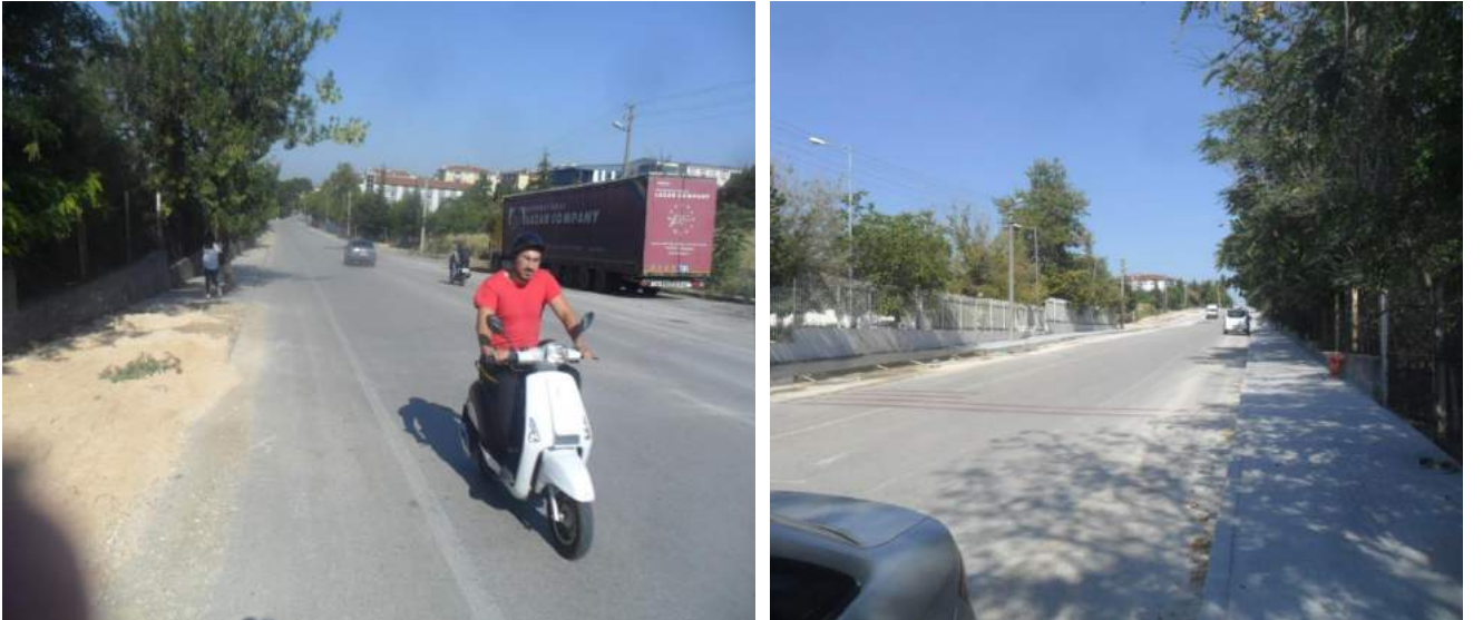
Şükrüpaşa Mahallesi Baskı Beton Kaldırım Yapılması
